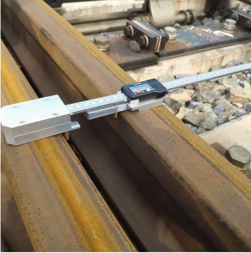
Ray makaslarında açıklık kontrolü - örnek saha uygulaması
